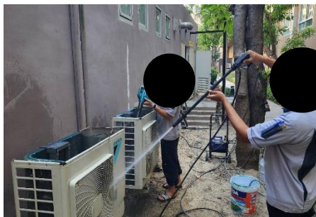
ภาพที่ 2.2-18 การล้างทำความสะอาดเครื่องปรับอากาศ
