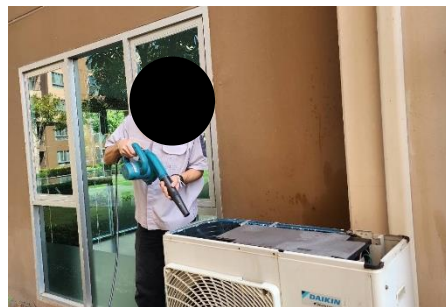
ภาพที่ 2.2-18 การล้างทำความสะอาดเครื่องปรับอากาศ
