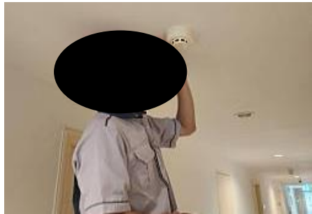
ภาพที่ 2.2-22 การตรวจสอบระบบป้องกันและเตือนอัคคีภัยในโครงการ
